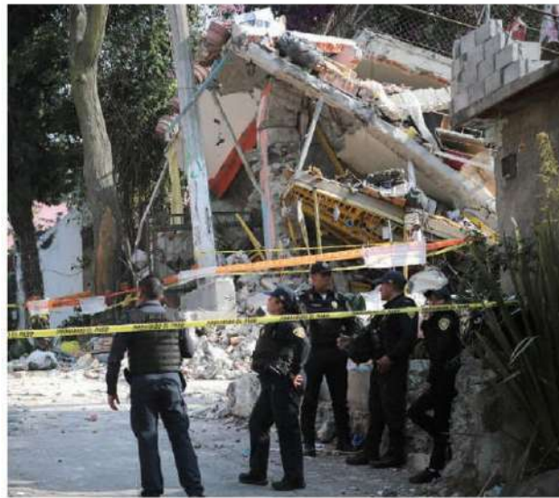
Explosión en vivienda de Tlalpan
