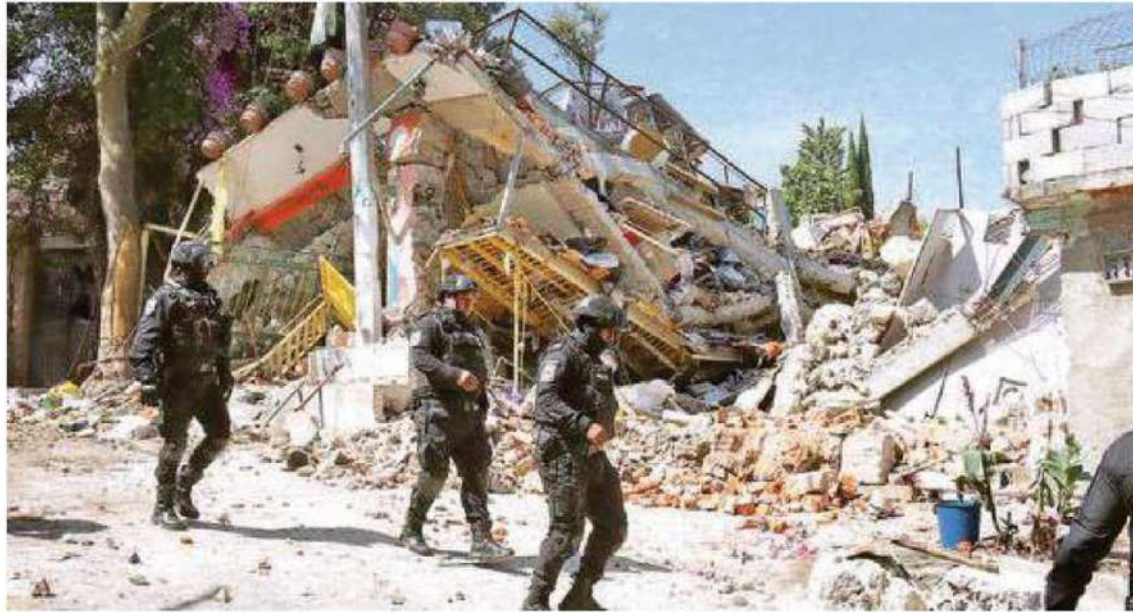
Una presunta fuga en un tanque gas estacionario causó la explosión al interior de la casa, la cual quedó derrumbada por completo junto con un predio aledaño /LUIS A. BARRERA
