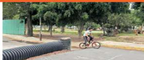
Una fractura visible atraviesa el Centro Deportivo Cananea.
