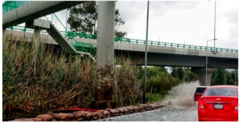
El puente vehicular "Cielito Lindo" sufre de encharcamientos ya que fue construido bajo un humedal.
