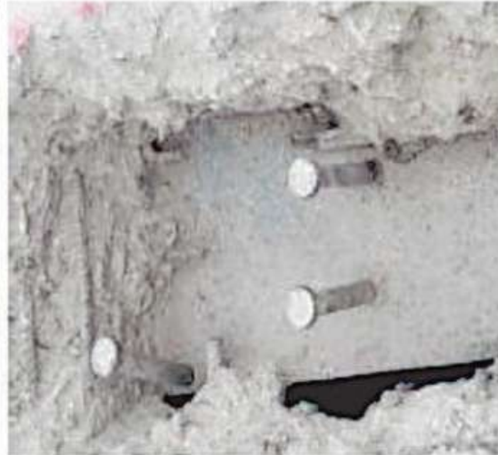
Del lado izquierdo se muestra la trabe con pernos correctos y del lado derecho, la parte con instalación incompleta
