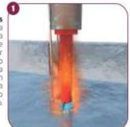
Proceso de soldadura de los pernos Nelson.
