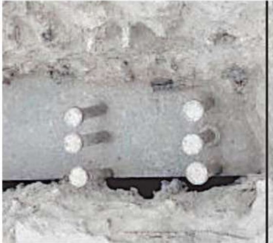
Del lado izquierdo se muestra la trabe con pernos correctos y del lado derecho, la parte con instalación incompleta
