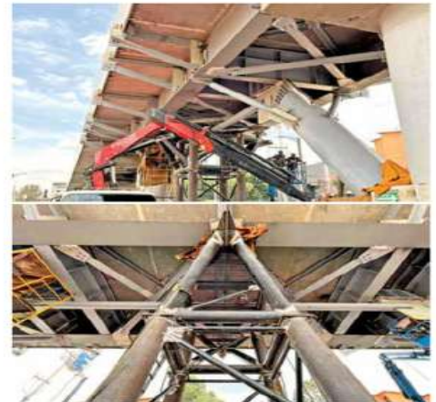
Fotos: Efrén Argüelles Así lucían ayer los avances del reforzamiento del viaducto elevado de acero, cuya parte colapsó el 3 de mayo de 2021.
