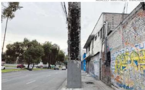
En Zaragoza sólo quedan los pilares del puente extinto
