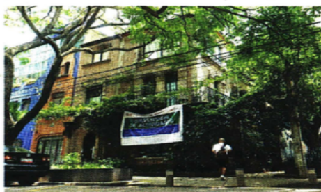
La mayor parte de las obras suspendidas se encuentran en la Alcaldía Cuauhtémoc.
