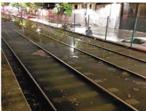
En Tren Ligero tuvo que parar operaciones por más de una hora por acumulación de agua a la altura de la estación Huichapan.
