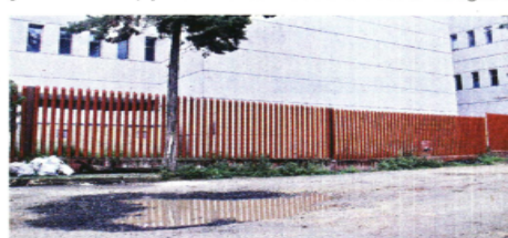
La Sedesa realizó trabajos de mitigación en el Hospital General, ubicado sobre la zona afectada por la falla en el suelo.
