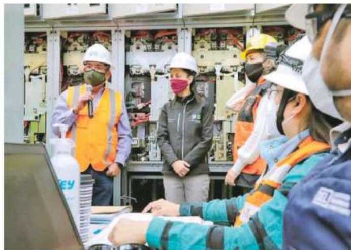
La jefa de gobierno, Claudia Sheinbaum, supervisó el minútame de las instalaciones emergentes en la Subestación Eléctrica Buen Tono /FOTO: CORTESIA GCDMX
