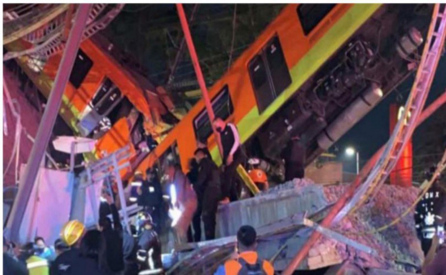
El 3 de mayo de 2021 una estructura elevada de la L12 se vino abajo entre las estaciones Tezonco y Olivos.
