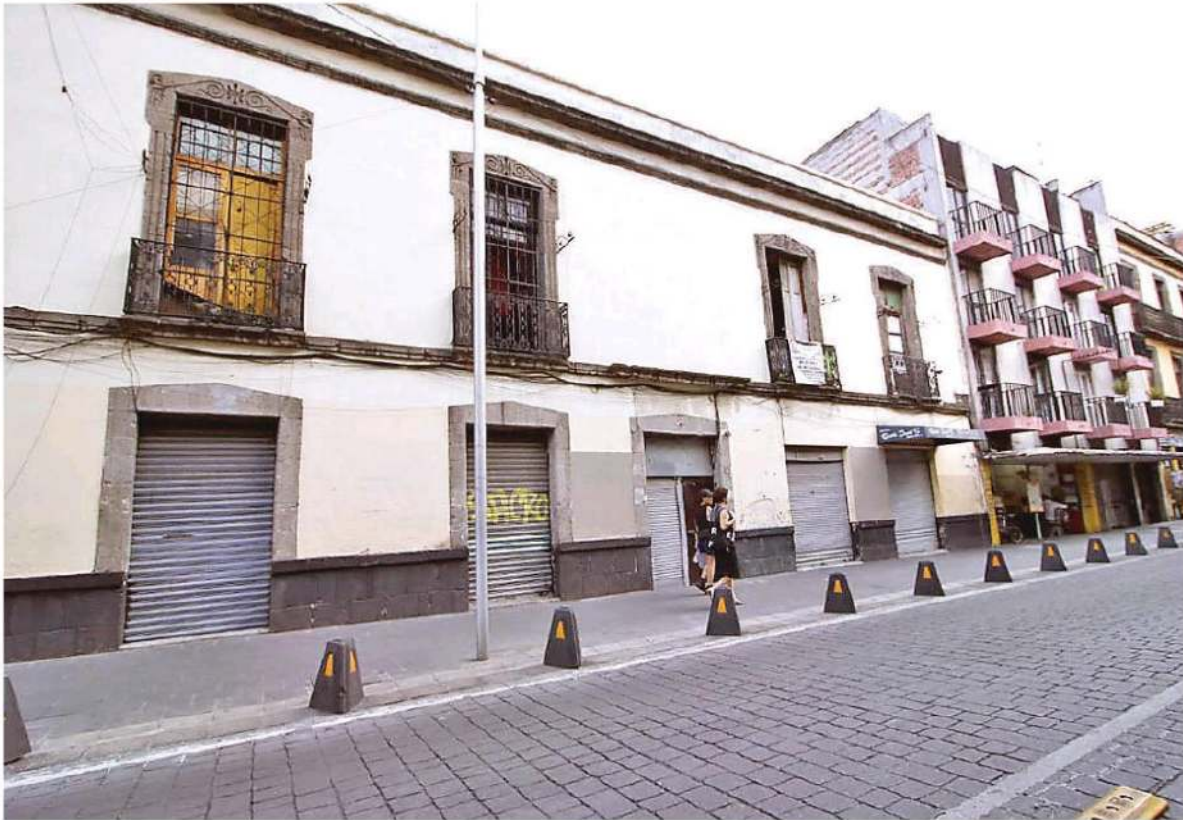
Algunos de los edificios que se encuentran en situación muy precaria son los ubicados en Guerrero número 81, Perú 24 y Belisario Domínguez 39 /FOTOS: JAIME LLERA
