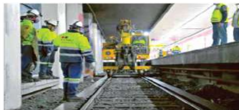
Aspectos del retiro de vías en la Línea 1 del Metro, lo cual difundió la jefa de Gobierno a través de su cuenta de Twitter.
