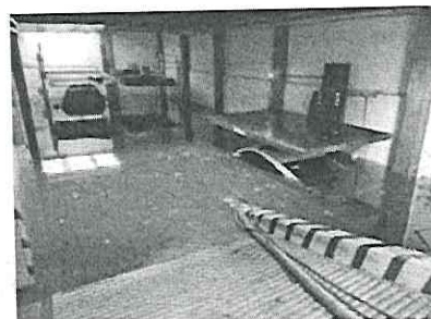
Aún se calculan daños económicos causados por la tromba.
