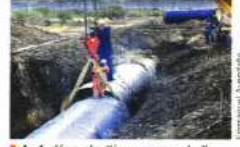
A 4 días de "inaugurado", el acueducto sigue en obras.
