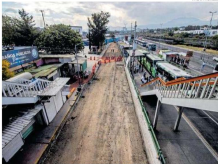
Trabajos de reencarpelado y bacheo en el Cetram Universidad
