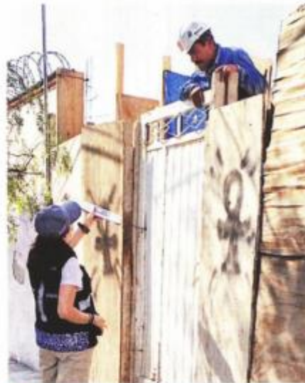
En la obra Calle San Federico, los responsables tampoco exhibieron permisos y les pusieron sello de suspensión.
