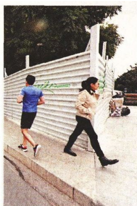
■ Obras que se realizan frente a la Torre BBVA complican el paso peatonal.
