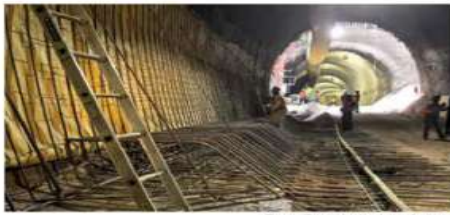
Fotos: Eduardo Jiménez/Archivo En marzo de 2017, se construyó la lumbrera de conexión de la L12 a la estación Observatorio, la obra inició en 2015.
