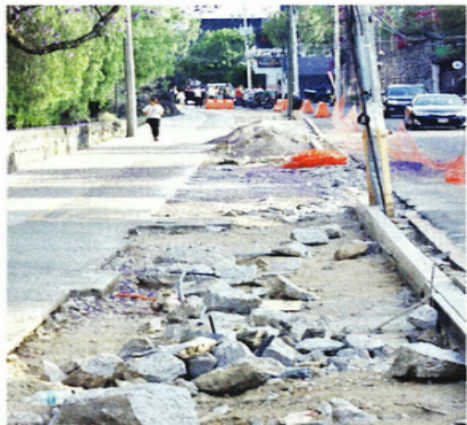
Las obras de ampliación de aceras en Jardine del Pedregal muestran tierra, escombro y, de trasfondo, malestar.
