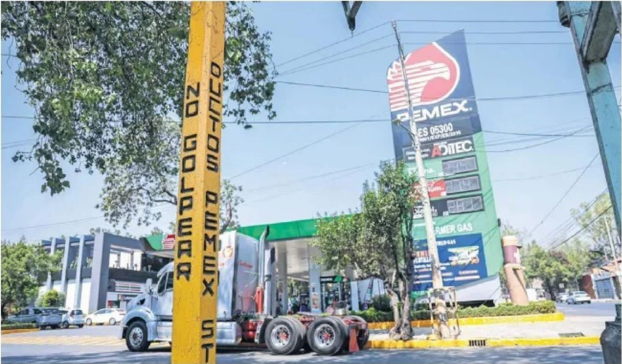
Sobre el camellón de la avenida Tezozómoc hay varios postes de Pemex en los que se anuncia el cruce de ductos.
