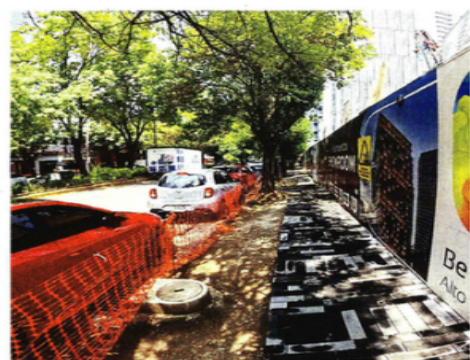
Las aceras rehabilitadas se encuentran acordonadas por malla ciclónica; peatones caminan entre terracería.
