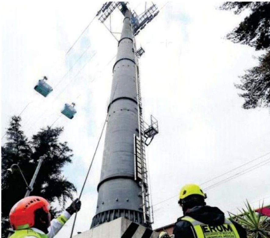
La emergencia se registró en la avenida Ticomán, a la altura de la calle Matagalpa, en la colo- nia Residencial Zacatenco
