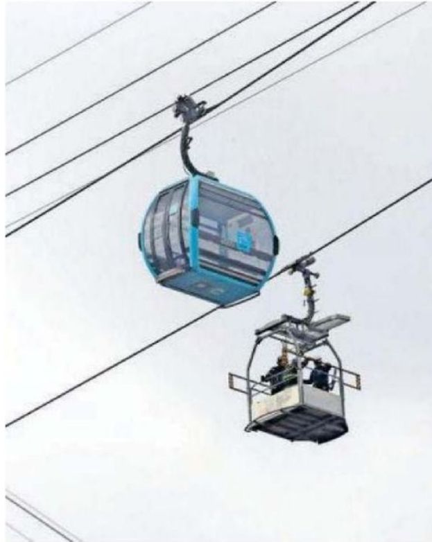
Temporalmente el ser- vicio del Cablebús, de Línea 1, fue suspendido entre las estaciones La Pastora e Indios Verdes
