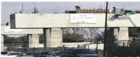
Aunque la instalación de dovelas se suspendió, trabajadores operaron ayer sobre el viaducto.
