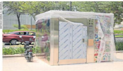
Uno de los sanitarios fue instalado sobre avenida Chapultepec y aunque aún no se define el costo, se podrá ingresar con la Tarjeta de Movilidad.
