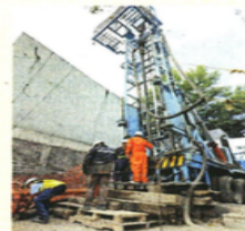
En septiembre se estima terminar con las obras.
