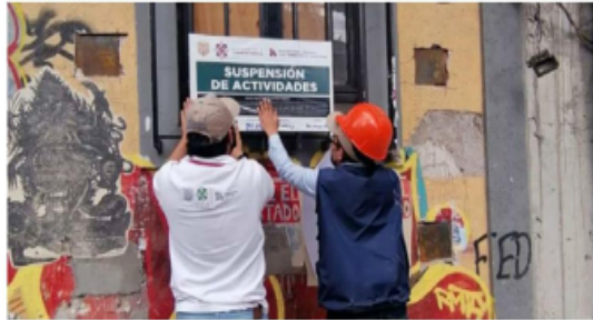
Realizaban trabajos de remodelación sin las autorizaciones correspondientes.
