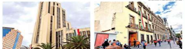
En el edificio de Argentina 8, en el Centro Histórico, se necesita "apuntalar la zona de pasillo". En tanto, la sede de la Lotería Nacional tiene "fisuras entre muros divisorios y estructura".
