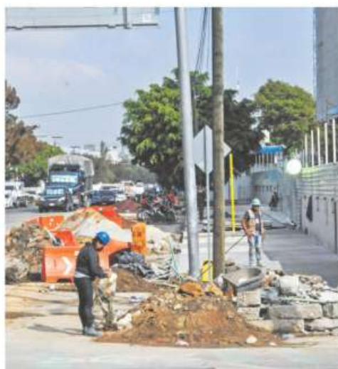
En 2019 Fibra Danhos comenzó la construcción
