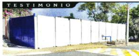
Uno de los pozos que abastecen de agua en Tecamachalco.
