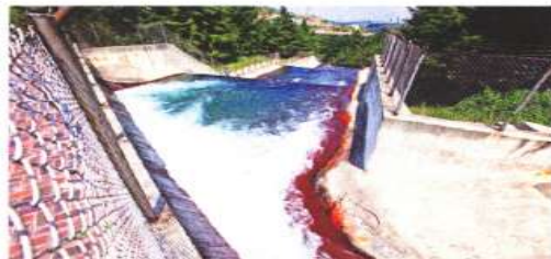
El convenio con CFE busca que el sistema Lerma tenga una correcta distribución de energía eléctrica para operar, aseguró la mandataria.
