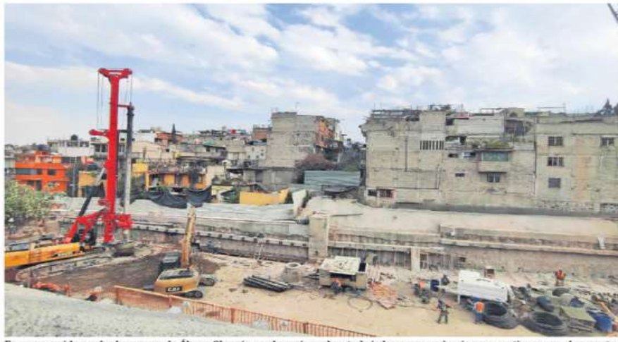
En un recorrido por las barrancas de Álvaro Obregón se observó que hay trabajadores y maquinaria para continuar con el proyecto.
