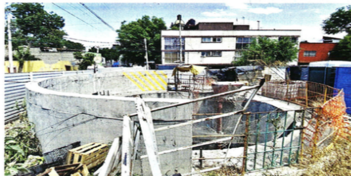
SIN AVANCE. A lo largo del trazo que expandirá la Línea 12 pueden observarse lumbreras, que son los accesos al nuevo tramos subterráneo.
