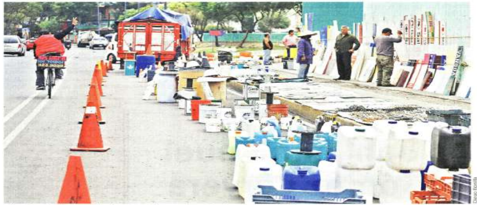
Puestos ambulantes están sobre el carril que será una ciclovia en Avenida Guelatao, en Iztapalapa.
