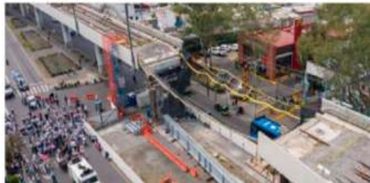
Trabajos en la Línea 12 del Metro
