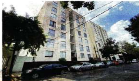
Al menos 105 departamentos conforman las cuatro torres que fueron reconstruidas tras el sismo.
