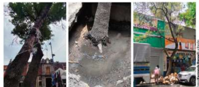
ALGUNOS EJEMPLARES están tan inclinados que chocan con inmuebles y cables.
