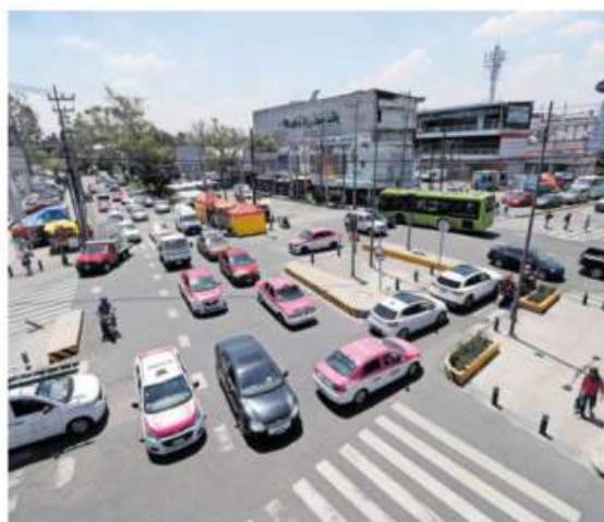
Implementar la infraestructura de cruce seguro, para evitar incidentes, además de operativos viales /IGNACIO HUITZIL
