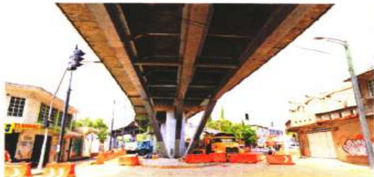
La intervención en el claro 22 tomará 12 semanas y se prevé colocar tres trabes metálicas y dos puntales de cada lado.
