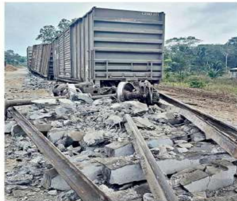
El paso de un tren destruyó los nuevos durmientes que son colocados en la vía del Istmo de Tehuantepec.
