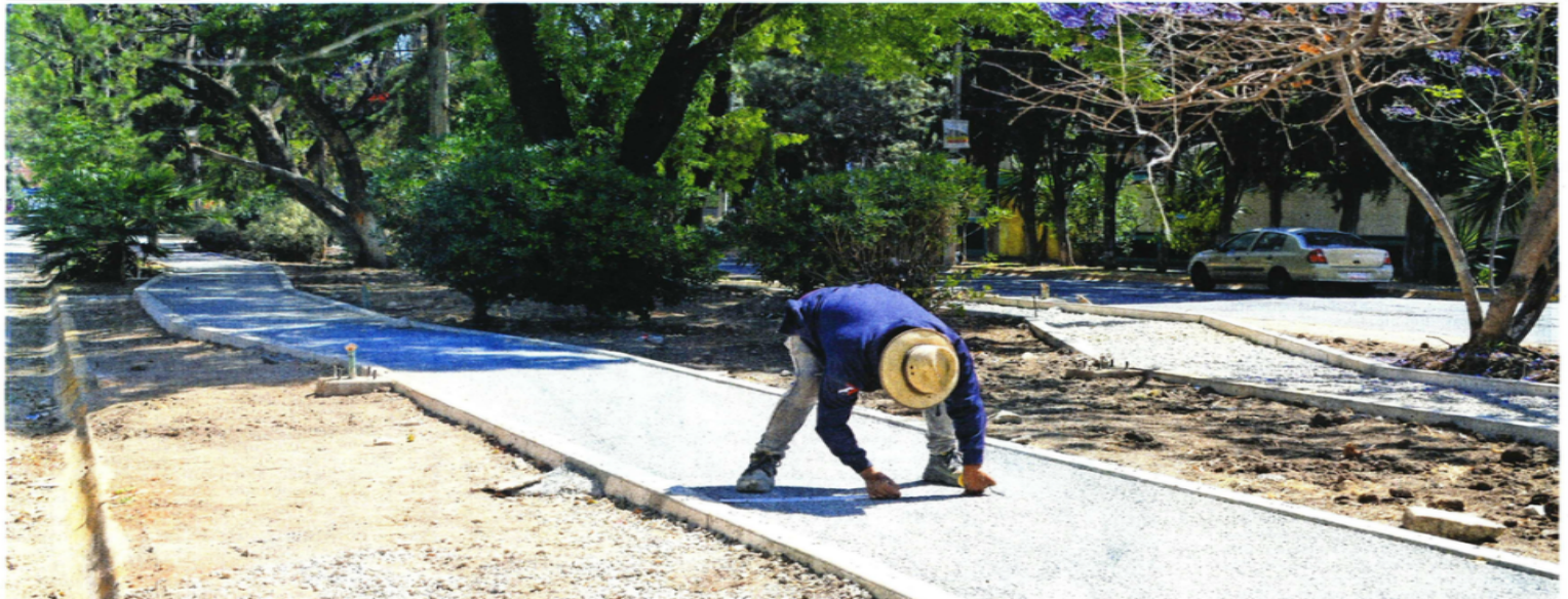
El parque lineal de Jardines de Atizapán es rehabilitado con el objetivo de convertirse en una de las primeras zonas donde el agua de lluvia se filtre al acuífero.
