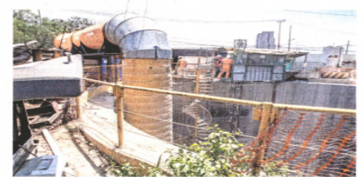
Aspecto de las excavaciones para la construcción del Metro; los colonos temen que en sus casas ocurran daños mayores.
