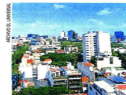
Es positivo que se construya vivienda social en las zonas tensionadas, dijo experto.
