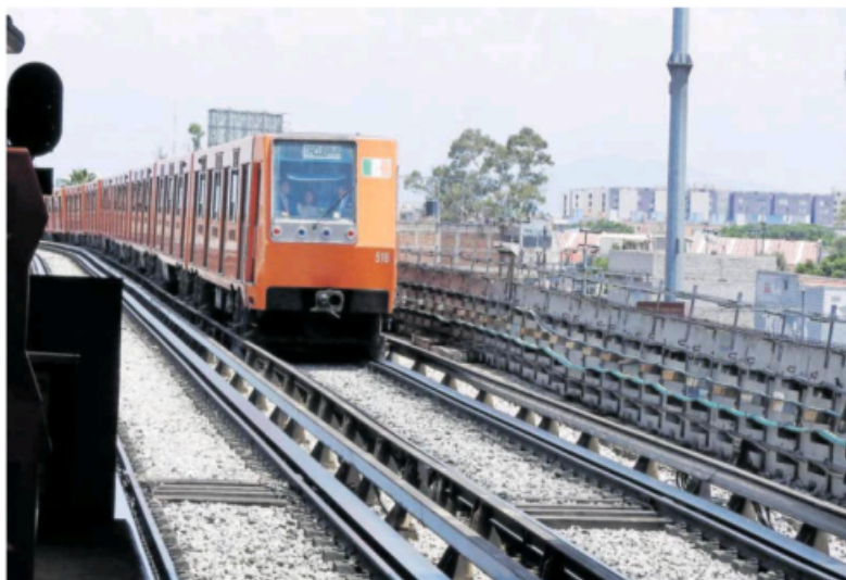
Este jueves se publicó en la Gaceta Oficial de la CdMx la licitación para los trabajos de renovación de las vías en la Línea 9 del STC Metro. /IGNACIO HUÍTZIL
