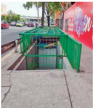
OBRAS. La remodelación de estos pasos peatonales, son parte de los trabajos que hay en Calzada de Tlalpan, explicaron.
