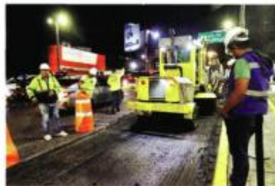
Los trabajos llegarán hasta el Kilómetro 13 de la México-Toluca.
