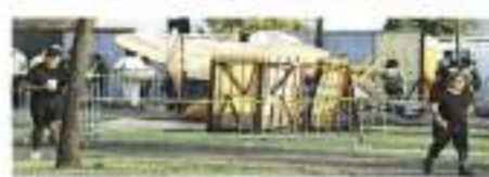
El sábado 5 de abril, una estructura colapsó mientras se llevaba a cabo el concierto en el Parque Bicentenario.
