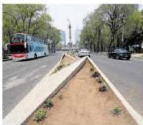
En estas jardineras solo queda tierra
