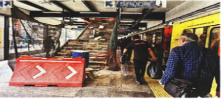
En la estación Viaducto de la Línea 2, usuarios conviven entre las obras que se realizan en el andén.
