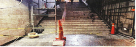
En Hidalgo, las escaleras lucen trabajos en desarrollo.
