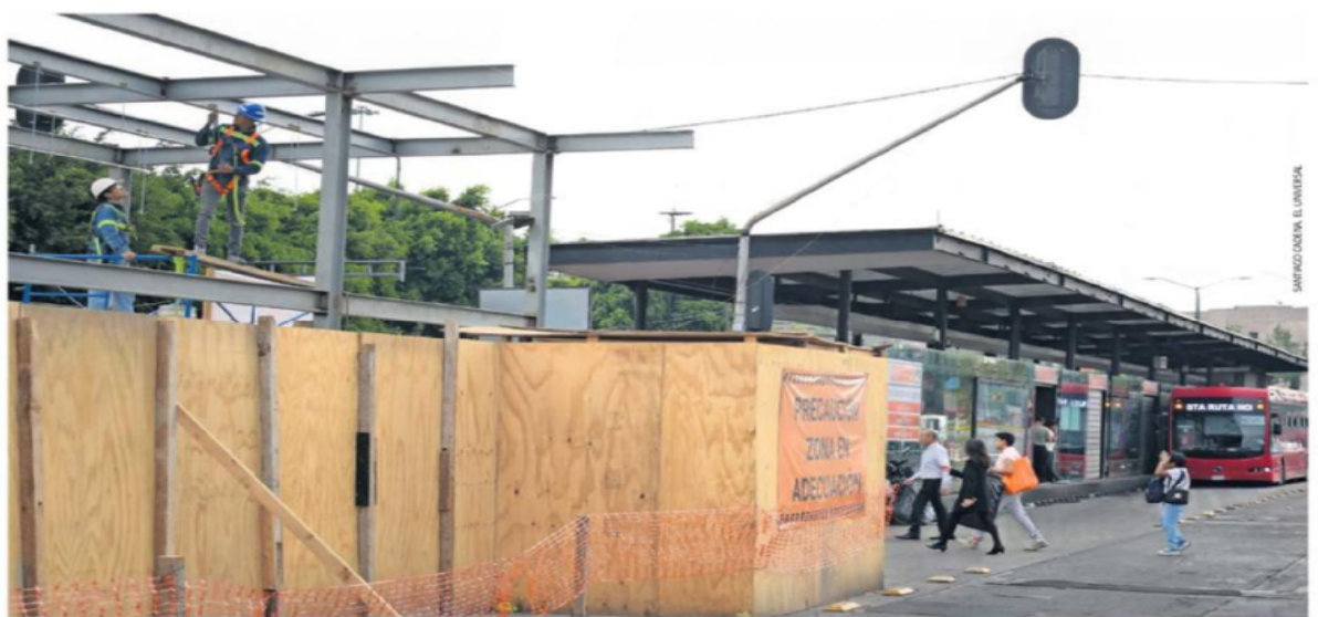
Al exterior de la estación permanecen colocados paneles de madera que delimitan el área de obra, mientras trabajadores realizan estructuras metálicas.
