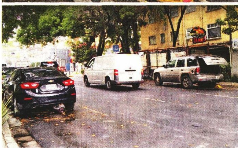
■ De los cuatro carriles con los que cuenta la vía, sólo dos están disponibles a la circulación.
