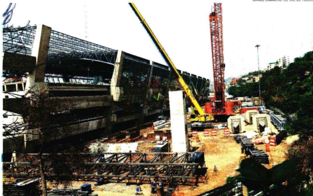
Las obras para concluir la terminal del Tren Interurbano avanzan a marchas forzadas; faltan escaleras, cristales y detalles en las vías
