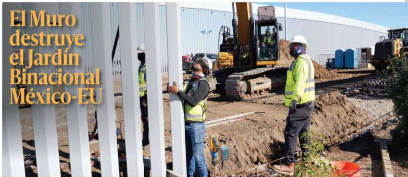
El Jardín Binacional, en la línea fronteriza entre Tijuana y San Diego, quedó reducido a casi nada luego de que obreros y maquinaria pesada le pasaron por encima para continuar la construcción del muro de nueve metros de alto ordenado por expresidente Donald Trump. PAG 17
