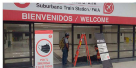
Será hasta septiembre de 2023 cuando el Tren Suburbano dé servicio.
