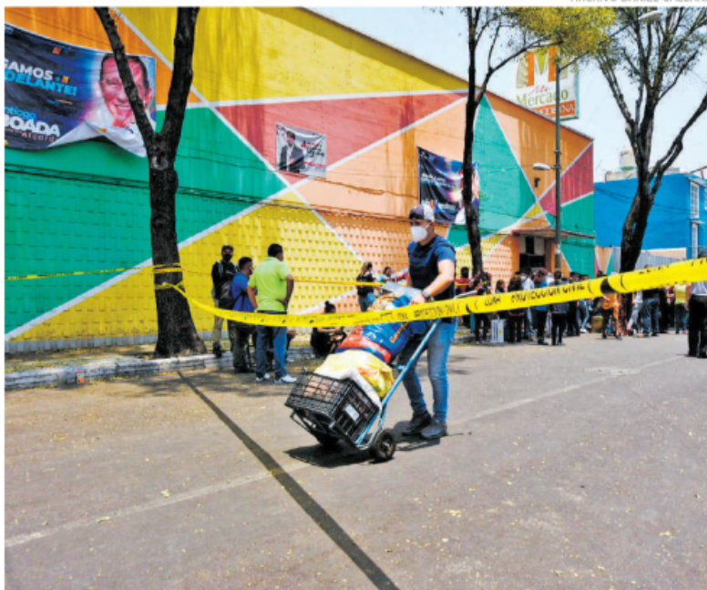
La Moderna vio en abril cómo su techo colapsó, ahora recibirá 25 millones de pesos
