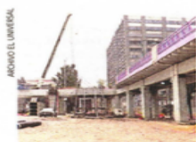
El skatepark de San Antonio Abad fue demolido en mayo.
