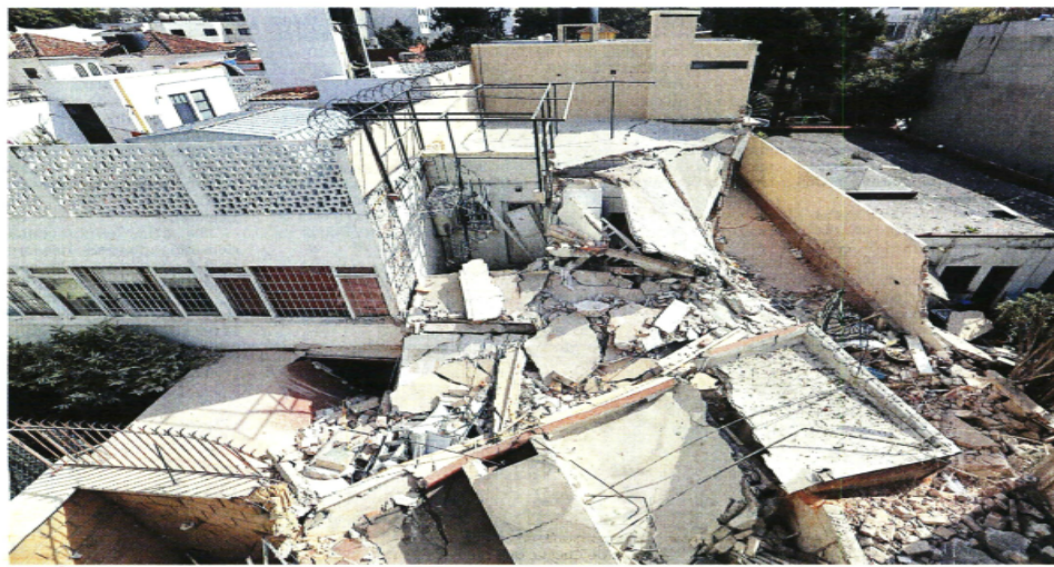
AL DÍA SIGUIENTE. La vista del derrumbe en Providencia, desde una vivienda ubicada en Agustín González de Cossío.
